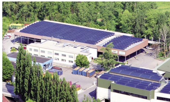
Das Fernheizkraftwerk AEVG in Graz, eine der größten Solaranlagen Mitteleuropas
